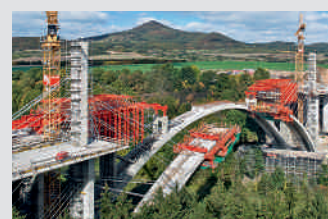
Encofrados para puentes
