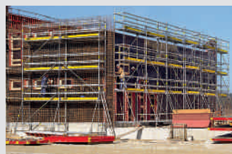
Andamios de trabajo para la construcción
