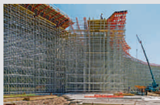
Cimbras y torres de carga
