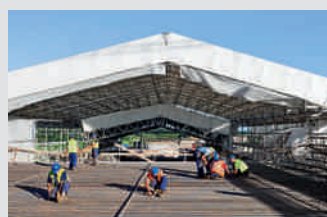
Andamios de protección
