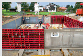
Encofrados para muros
